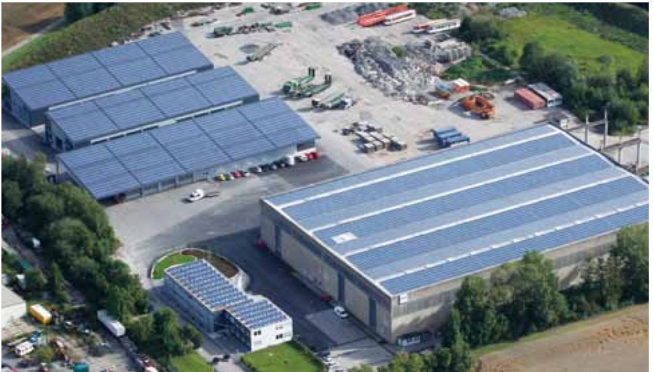
Novatech | Michelfeld-Erlin - Allemagne Anlage: 1,4 MW | Fixation panneaux solaires
