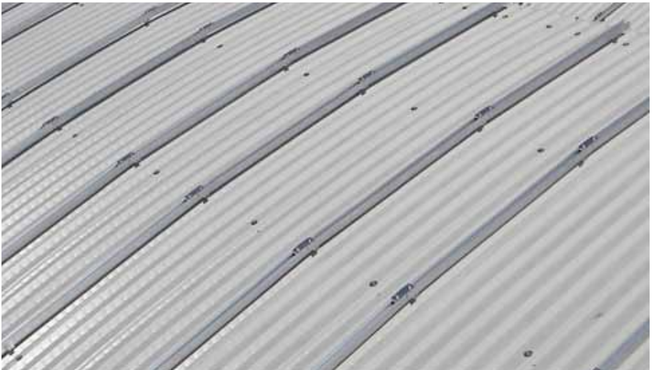
Elpo | Brixen - Italie Anlage: 88,83 kW | Fixation panneaux solaires
