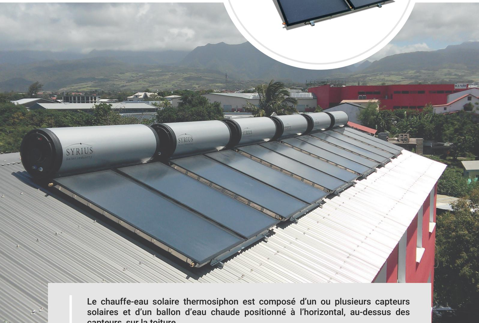
Le chauffe-eau solaire thermosiphon est composé d'un ou plusieurs capteurs solaires et d'un ballon d'eau chaude positionné à l'horizontal, au-dessus des capteurs, sur la toiture.
